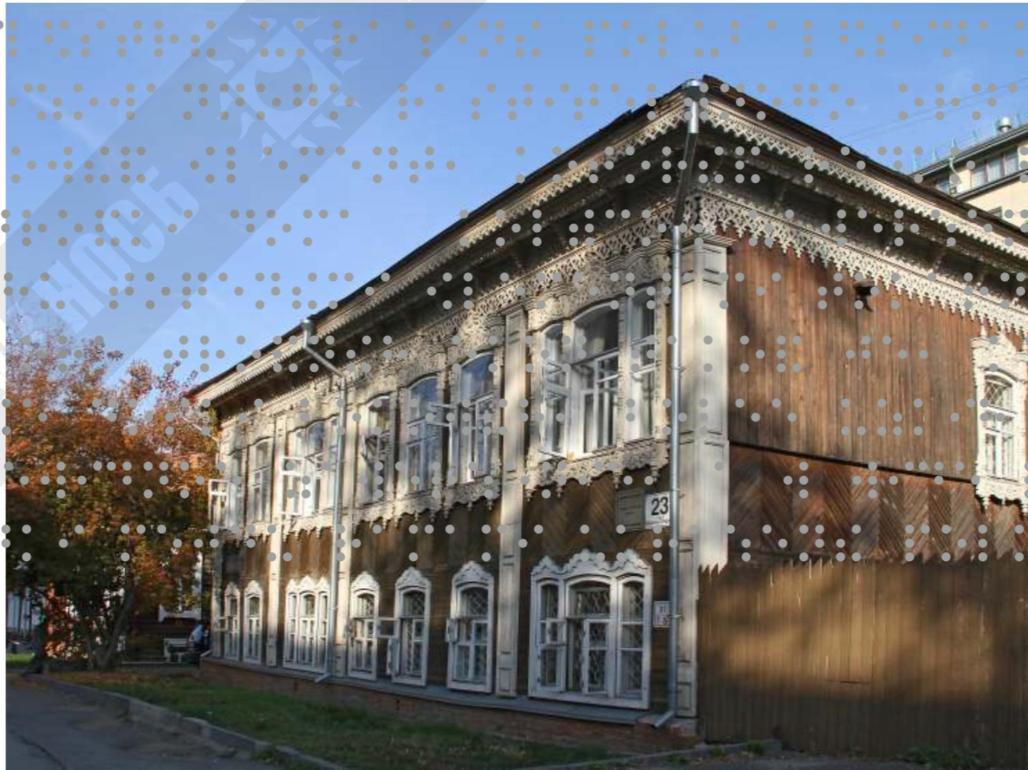
Боковины-пилястры украшены полубалясинами, элементами стилизованного растительного орнамента и даже имеют новый элемент, который редко применялся во времена постройки дома – кольцо. Завершены боковины снизу и сверху точеными элементами токарной работы. Характер декора тройных окон такой же, как и одинарных, но надоконные доски боковых, более узких частей окна имеют не килевидное завершение, а в виде пологой криевой; простенки между рамами украшены полубалясины-
