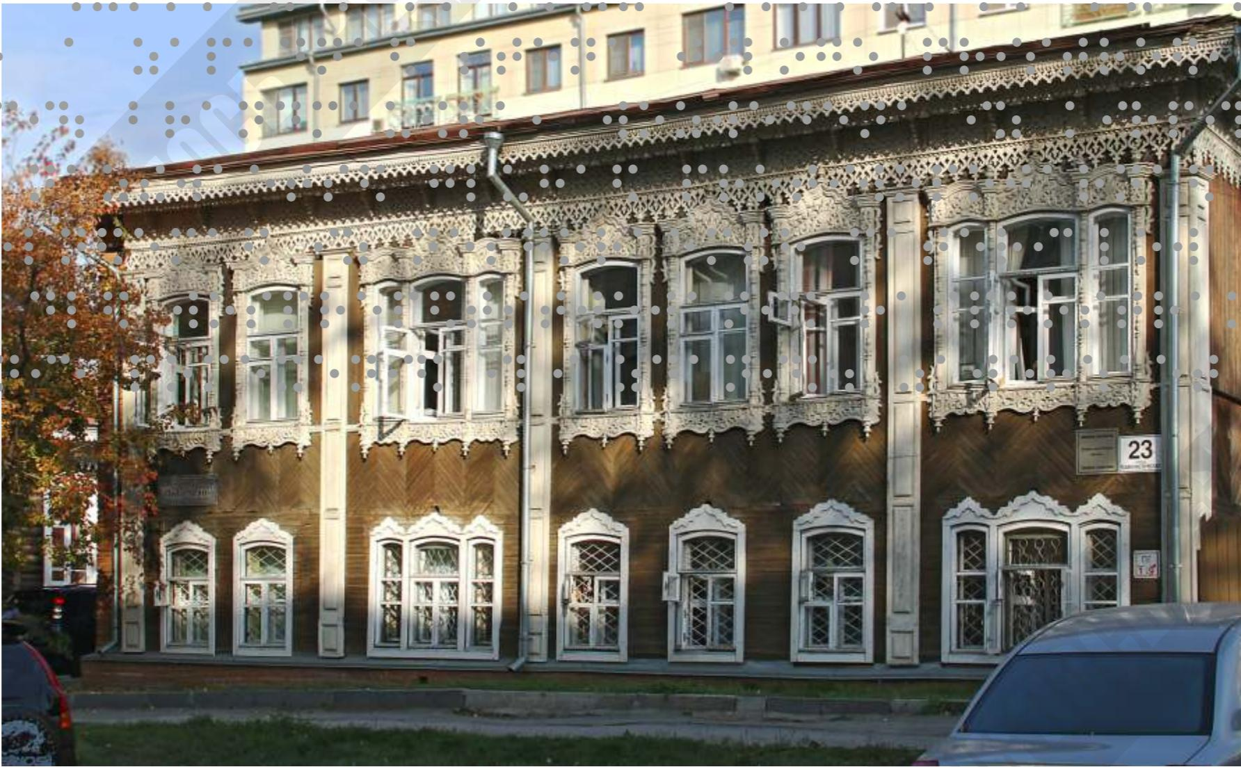
Здание поставлено на кирпичный фундамент, переходящий в невысокий кирпичный цоколь. Стены дома обшины тесом, а западная стена жилого пристроя, выполняющая функцию брандмауэра, возведена из кирпича. Брандмауэр называется глухая противопожарная стена здания, выполняемая из несгораемых материалов и предназначенная для воспрепятствования распространению огня на соседние помещения или здания. Завершает здание
