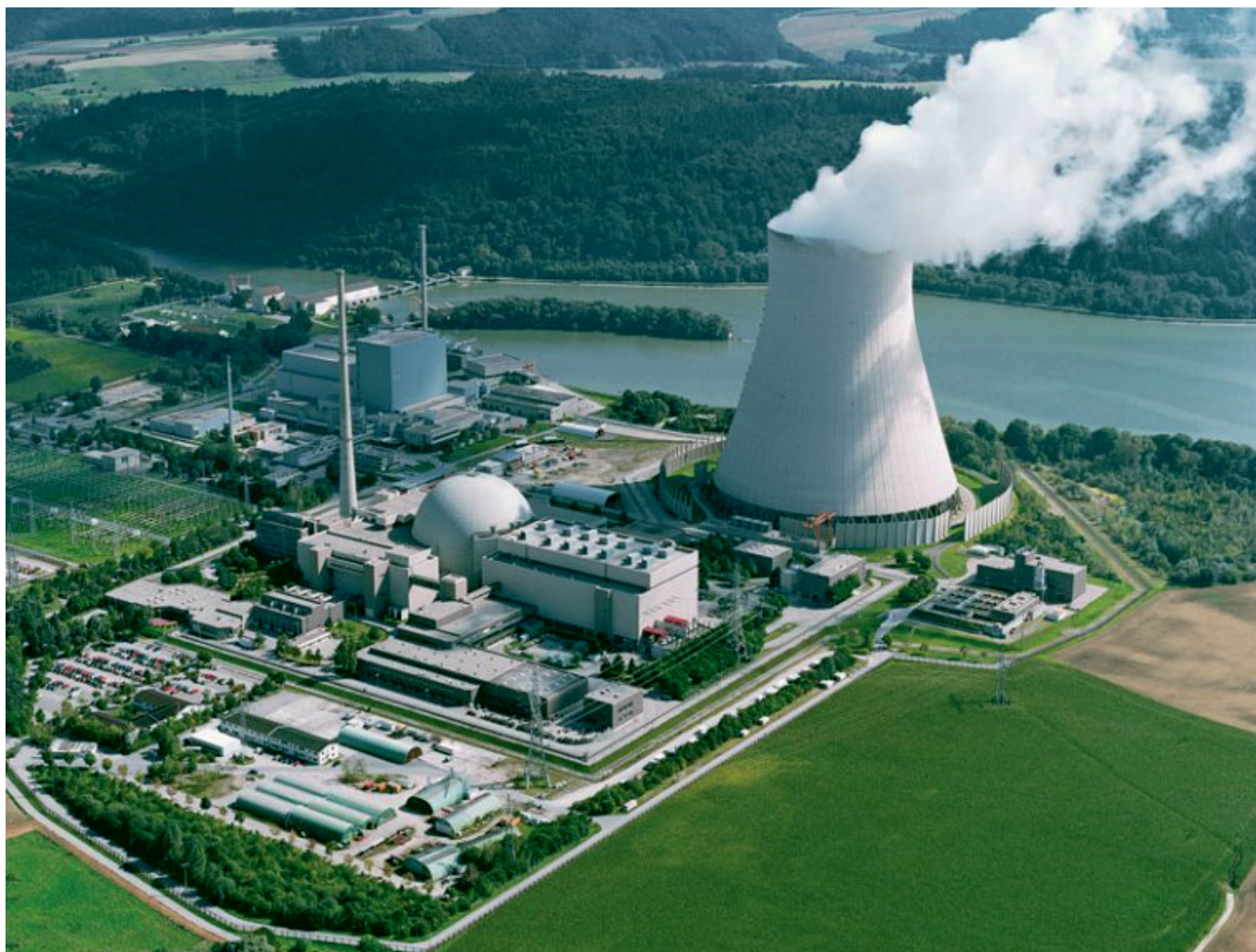
На фото: внешний вид АЭС
